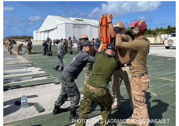
Accompagné de militaires japonais, américains, et australiens, le cpl Samuel Létourneau, du génie construction de la 2 e Escadre, au centre, participe à la formation sur la réparation rapide des dommages et l'installation de plaques d'aérodromes. / Accompanied by Japanese, American and Australian soldiers, Cpl Samuel Létourneau, from the construction engineering of the 2 Wing (in the center) participates in training on the rapid repair of damage and the installation of airfield plates.
